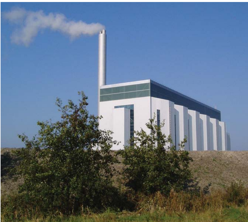
Planta de Reno-Nord, Aalborg
