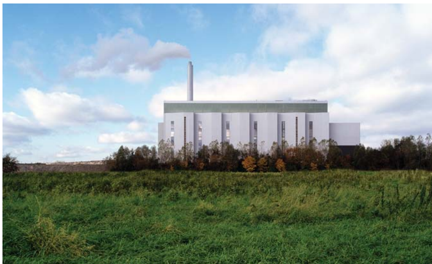
Planta de Reno-Nord, Aalborg
